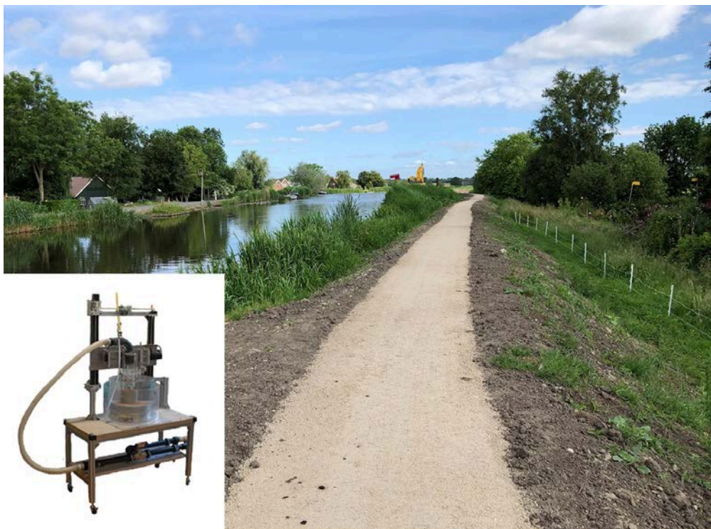
Bestaande weg met halfverharding van Graustabiel op kruin van een regionale waterkering (Foto: De Beijer) met als inzet de opstelling van de jet erosie test bij GeophyConsult in Frankrijk. (Foto: GeophyConsult)
